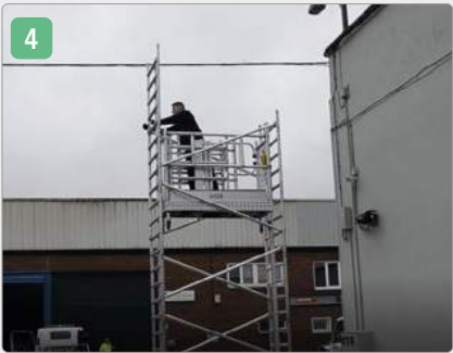
Colocar las abrazaderas.
