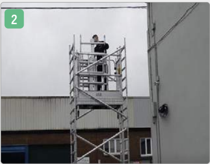
Elevar la plataforma la altura necesaria.
